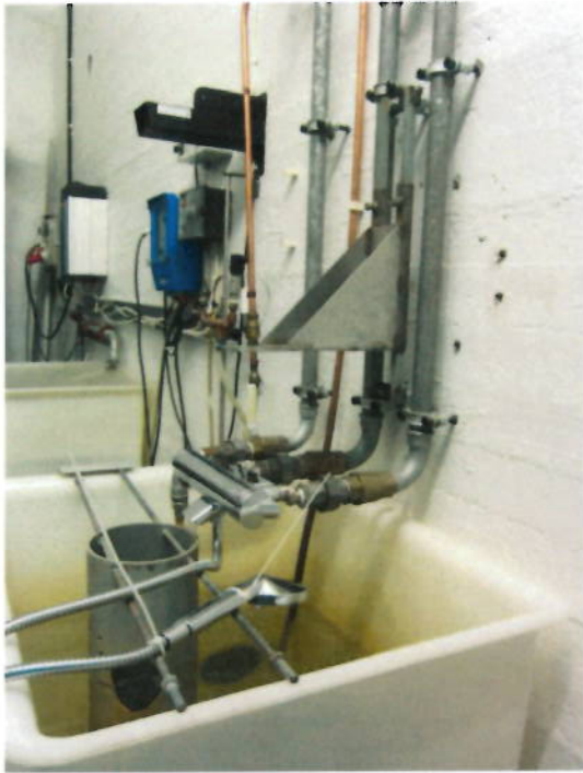
Kuva 1. Mittaus hana asennettuna
