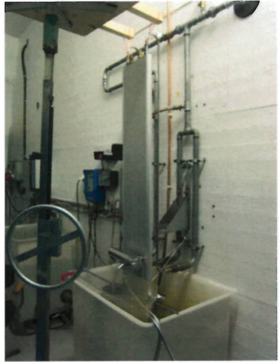
Kuva 2. Mittaus kuivauspatteri + hana asennettuna
